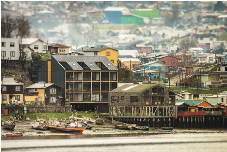
Imagen 4: Edificio Estación (fuente: © Federico Cairoli, 2019)
