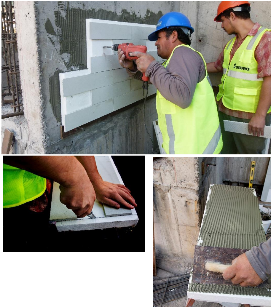
Figura 2. Aplicación de envolvente térmica exterior tipo EIFS. Fuente: Enchape Térmico EIFS | Petromur. http://www.petromur.cl
