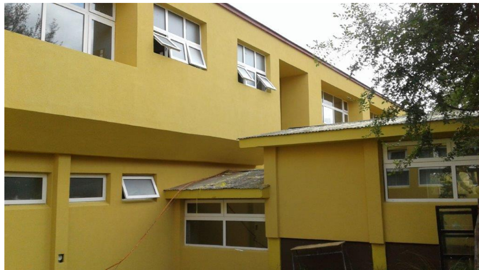
Figura 5. Proyecto terminado Mejoramiento Envoltente Térmica, Escuela Fuerte Baquedano, Coyahique. Fuente: Departamento de Infraestructura Escolar, Mineduc.
