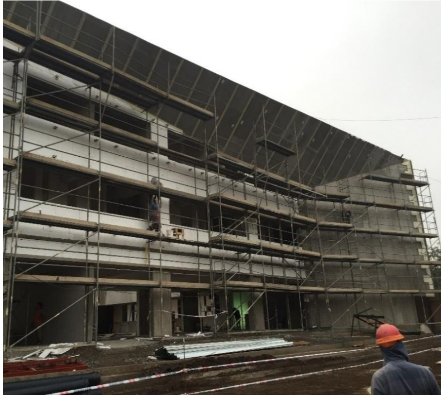
Figura 6. Instalación Sistema EIFS Envoltente Térmica, Proyecto Sello Liceo Artístico de Quinta Normal, Región Metropolitana. Fuente: Departamento de Infraestructura Escolar, Mineduc
