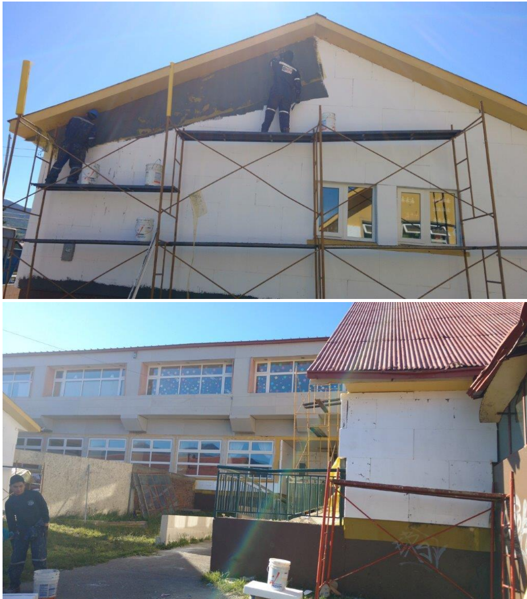
Figura 4. Instalación Sistema EIFS Proyecto Mejoramiento Envolvente Térmica, Escuela Fuerte Baquedano, Coyahique. Fuente: Departamento de Infraestructura Escolar, Mineduc.
